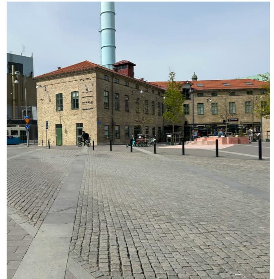
Figur 136. Enhetligt golv på Esperantoplatsen i Göteborg (COWI, 2025).
