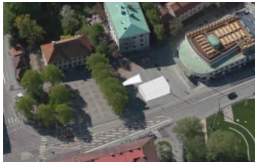
Figur 90. Flygbild med placering av entrébyggnad och lanternin på Stigbergstorget (AFRY, 2025).
