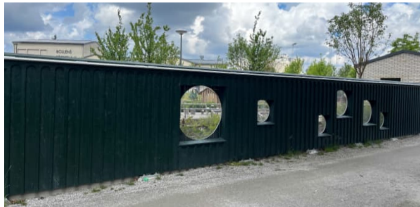
Figur 181. Exempel på hur man kan göra tithåll för att synliggöra det pågående arbetet för stora och små, i Malmö (COWI, 2025).
