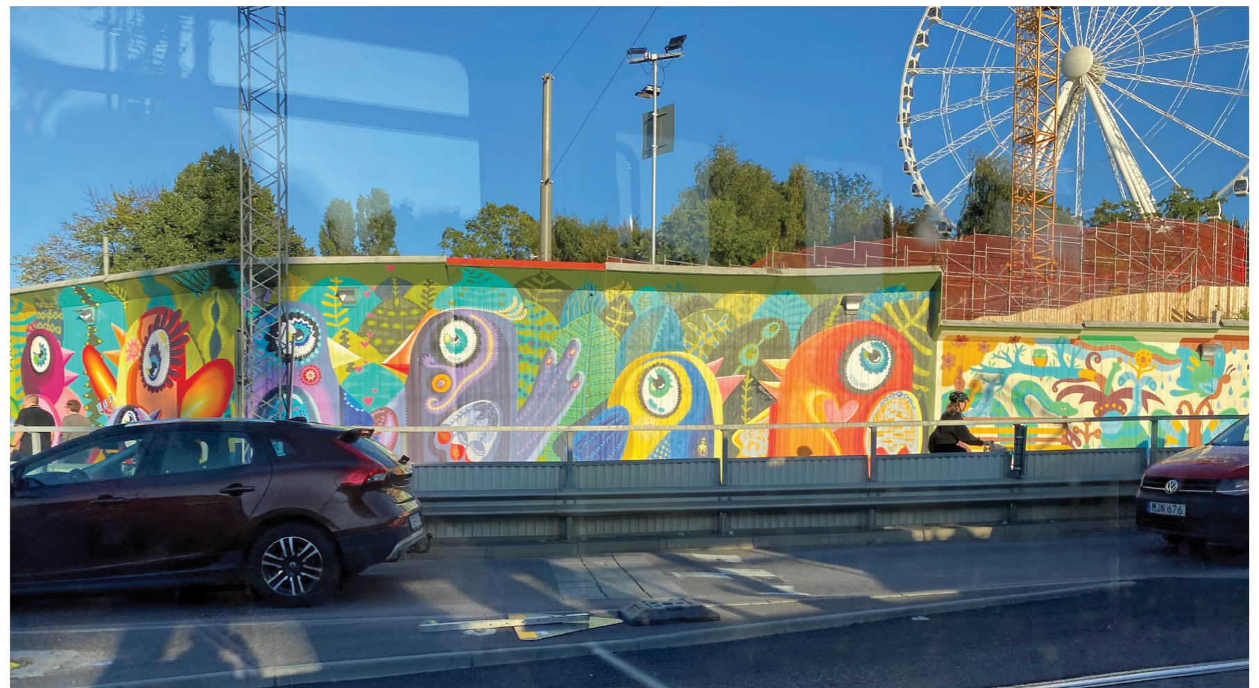
Figur 177. Exempel på plank som avskärmning kring byggarbetsplats vid Korsvägen i Göteborg. Planket har dekorerats med konst i form av muralmålningar (AFRY, 2025).
